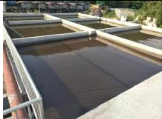
现有洗车废水沉淀池
