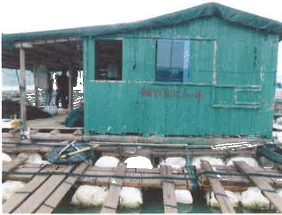
图7 管理房现场图
