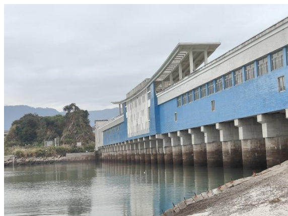
松山围垦水闸闸后
