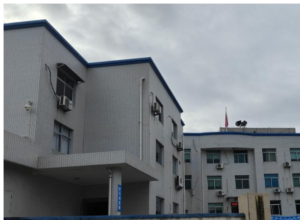
福建省罗源松山围垦管理处办公楼
