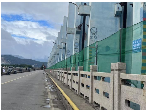
松山围垦水闸闸前
